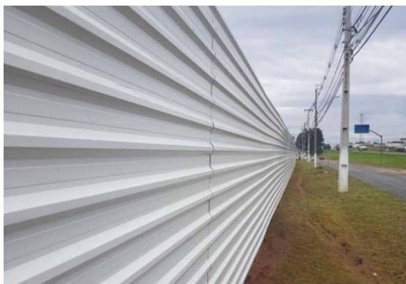
Imagem – Exemplo de tapume com telha metálica trapezoidal
